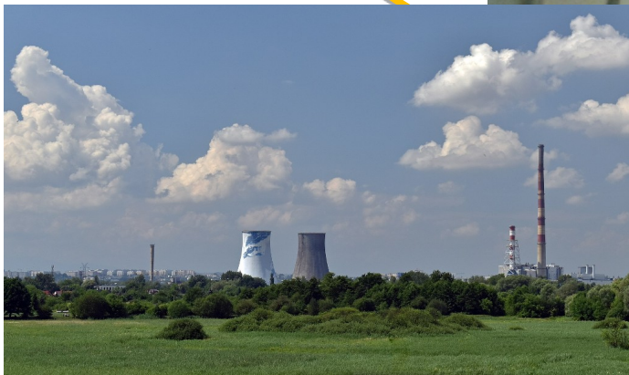
Elektrociepłownia w łęgu - moc zainstalowana 460 MW :)
